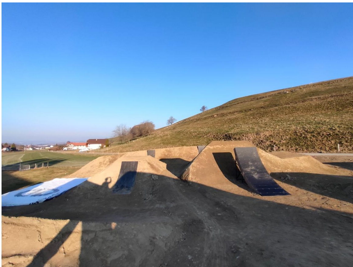
Image lors des travaux
